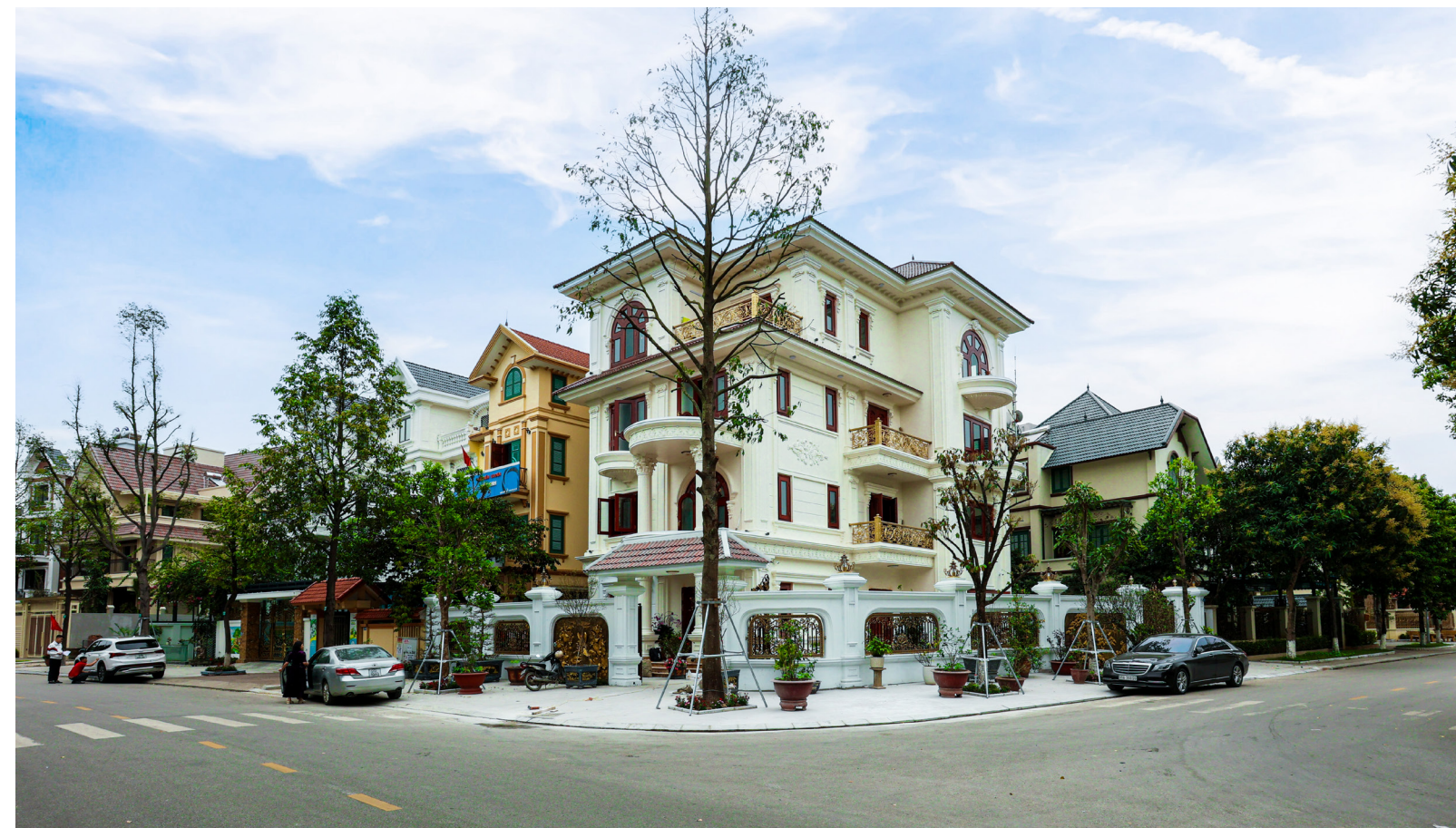
Nhà phố liền kề điển hình
